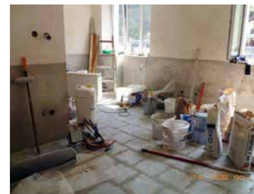
Omítku obnovte, až když je stavba opravdu suchá.
