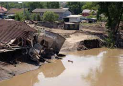
Velká povodeň dokáže odnést celý dům.
