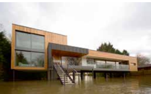
Novostavby v záplavových územích by měly být navrženy s ohledem na povodně.
