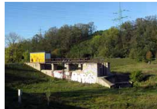
Suché nádrže slouží k zadržení vody za povodni. Suchá nádrž Čihadla.
