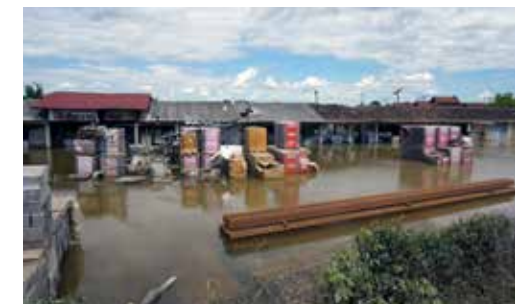
Povodně se neomezují pouze na obytné domy.
