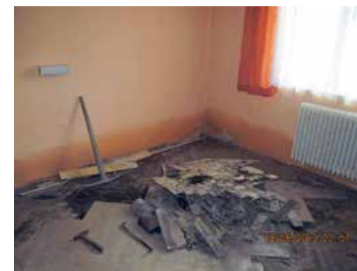
Parketové a plovoucí podlahy je potřeba odstranit.
