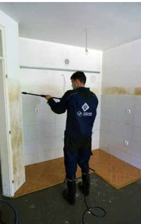
Tlakový čistič VAP je nejúčinnější způsob, jak se zbavit bahna a ostatních nečistot.
