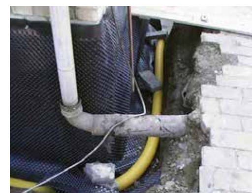
Drenážní trubka před zásypem štěrkem.
