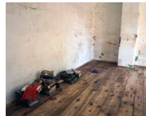
Vyčistěte stěny a podlahu, jak nejlépe můžete.
