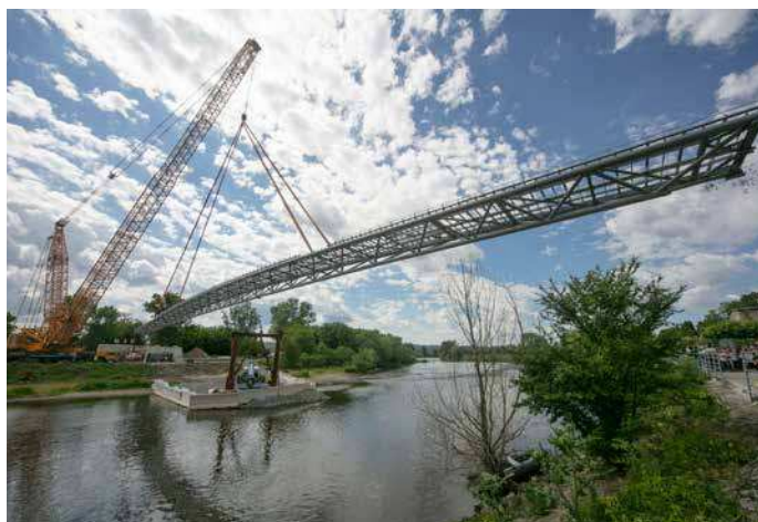
▲ Obr. 15 Konstrukce lávky byla vcelku jeřábem přemístěna na opěry, pilíř a provizorní podporu v řece (foto: Tomáš Lébr)
