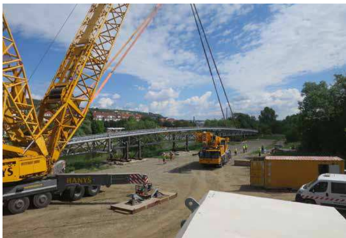
▲ Obr. 14 Předmontovaná lávka na pravém břehu před zdvihem
