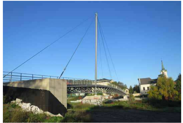
▲ Obr. 13 Rozšíření zbraslavské opěry s dvojicí lanových závěsů
