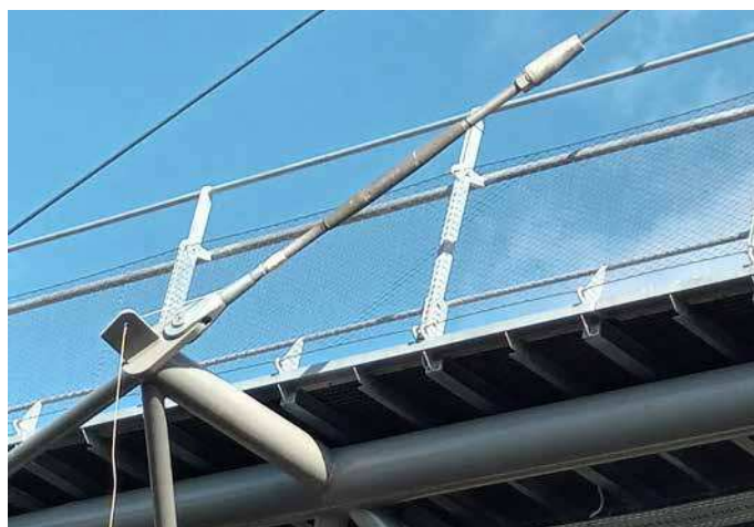
▲ Obr. 9 Na návodní straně jsou lana kotvena do konzol o délce 1,4 m
