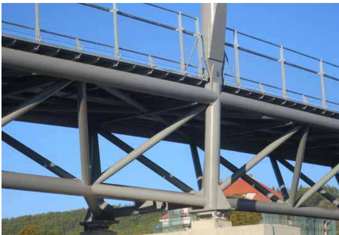
▲ Obr. 6 Uložení lávky na ložiscích na pilíři (P2) a kotvení pylonu do horního pasu konstrukce lávky
