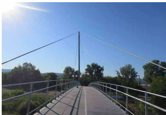
▲ Obr. 11 Kompozitní mostovka a zábradlí s výplní z nerezové sítě
