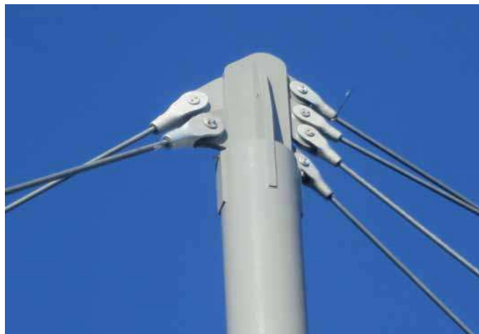
▲ Obr. 7 Zakončení lan ve vrcholu pylonu
